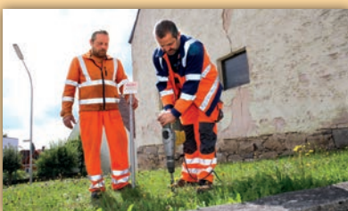
Bauhofmitarbeiter beim Aufstellen der Blühflächenschilder
